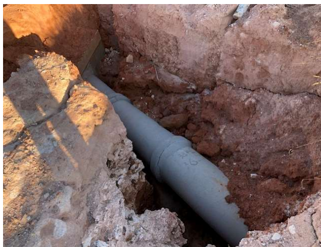
FOTO 16: RUA 05 – GALERIAS DE ÁGUAS PLUVIAIS.
