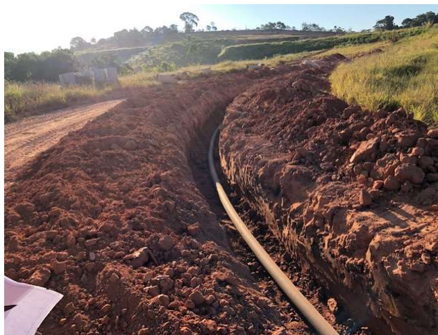
FOTO 18: RUA 02 – REDE DE ÁGUA.
