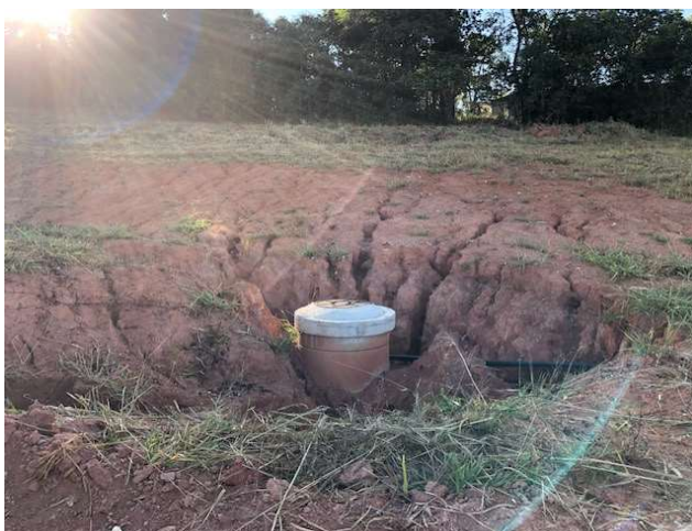
FOTO 11: RUA 06 – PV DE ESGOTO.
