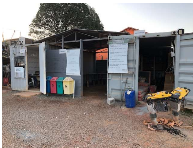
FOTO 30: INSTALAÇÕES PROVISÓRIAS DO CANTEIRO DE OBRAS.
