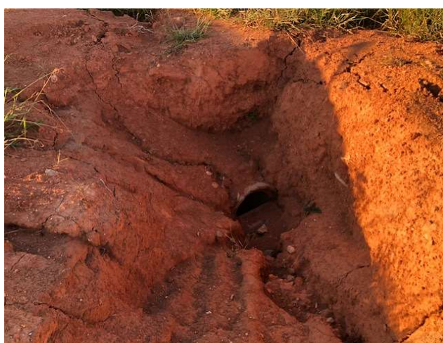
FOTO 23: RUA 03 – PV DE ESGOTO.
