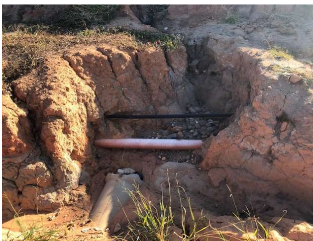
FOTO 05: RUA 02 – REDES DE ÁGUA E ESGOTO.
