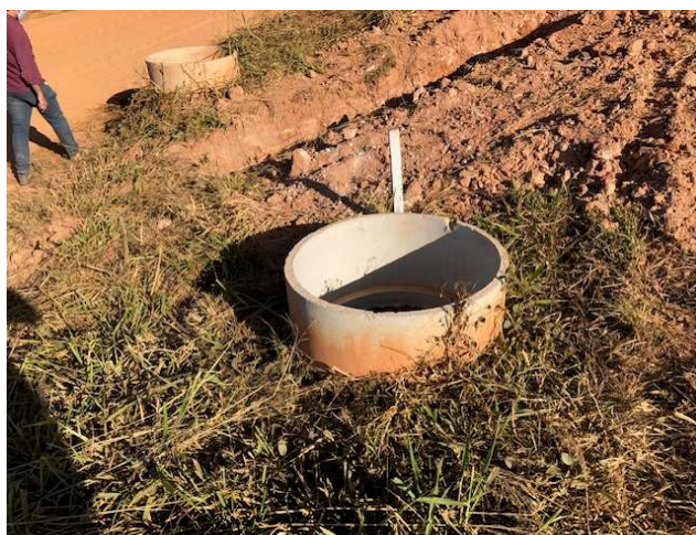
FOTO 02: RUA 08 – PV. DE ESGOTO.
