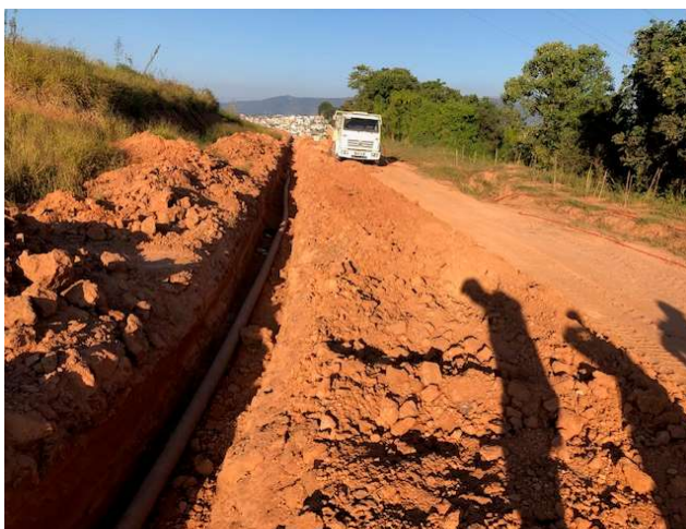
FOTO 19: RUA 02 – REDE DE ÁGUA.
