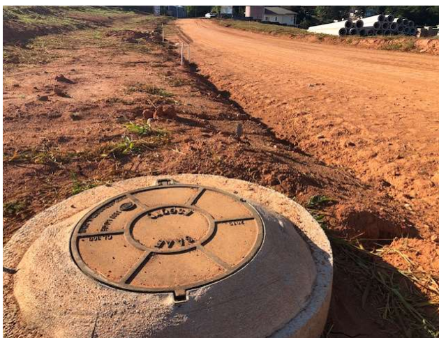
FOTO 07: RUA 07 – PV. DE ESGOTO.
