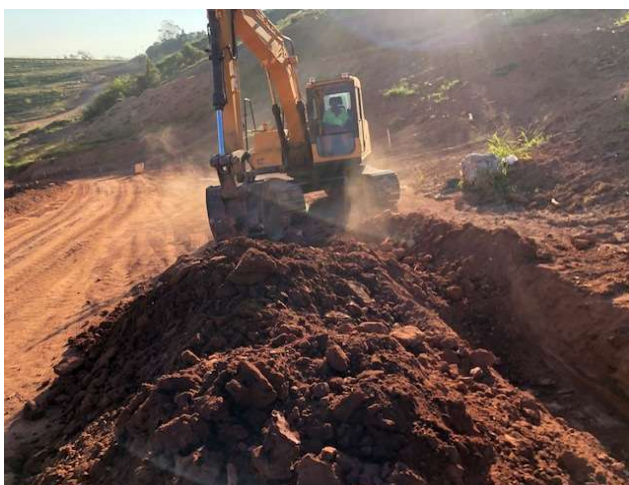
FOTO 20: RUA 02 – ABERTURA DE VALA PARA REDE DE ÁGUA.
