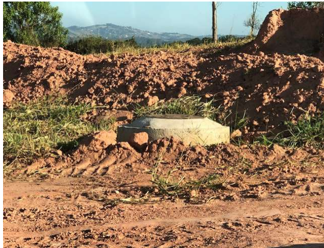
FOTO 13: RUA 09 – PV DE ESGOTO.
